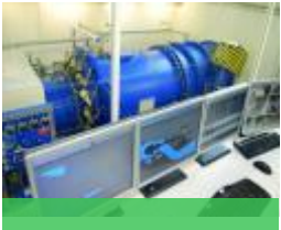
Sistemas de Control para plantas Hidro Electricas
