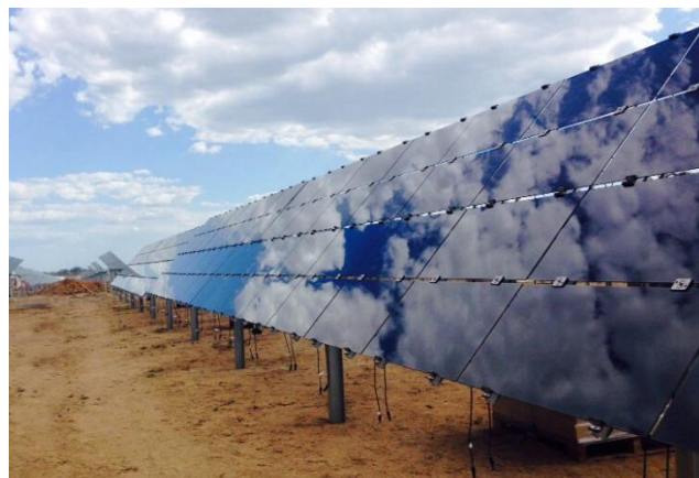
Central Solar del Sur Honduras
