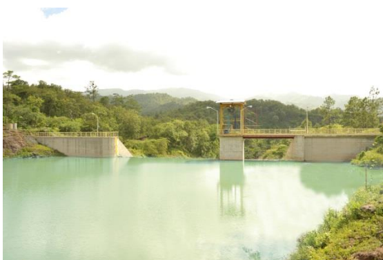
Central Hidroeléctrica Cuyamapa Honduras
