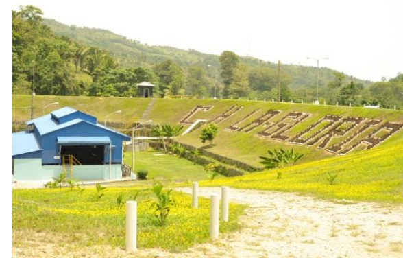
Central Hidroeléctrica La Gloria Honduras
