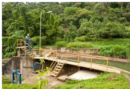
Central Hidroeléctrica Papaloate El Salvador
