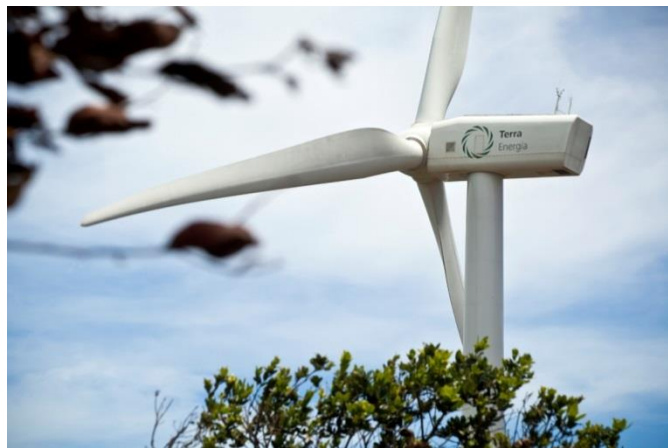
Central Eólica San Marcos Honduras
